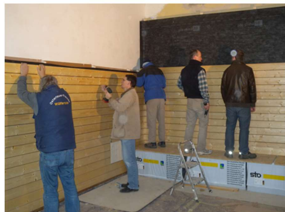
Einbau der Prallwände in Eigenleistung
