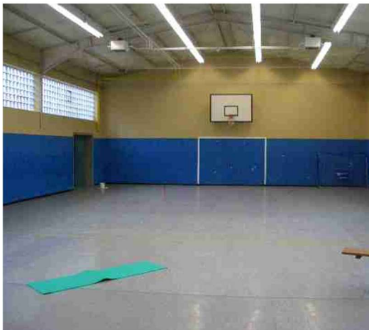
Turnhalle nur noch Bolzhalle. Im Boden bildeten sich Stolperfallen. Was nun?
