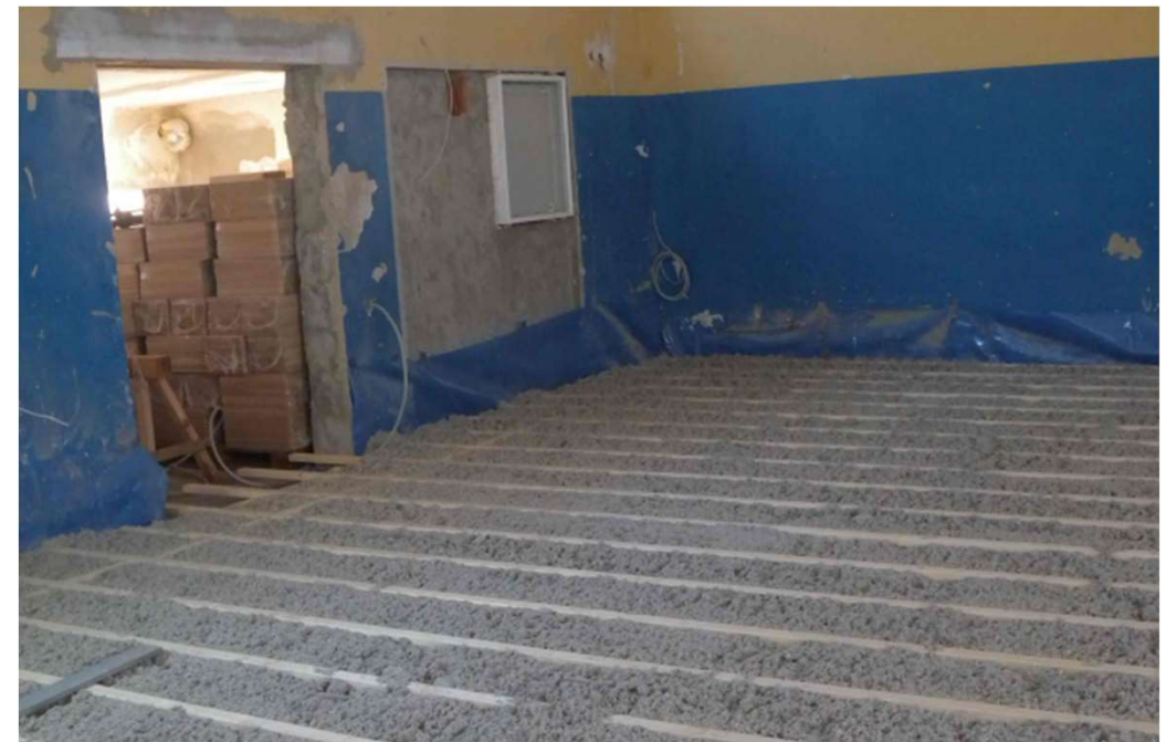
10 cm Dämmung im Boden – mehr ging nicht
