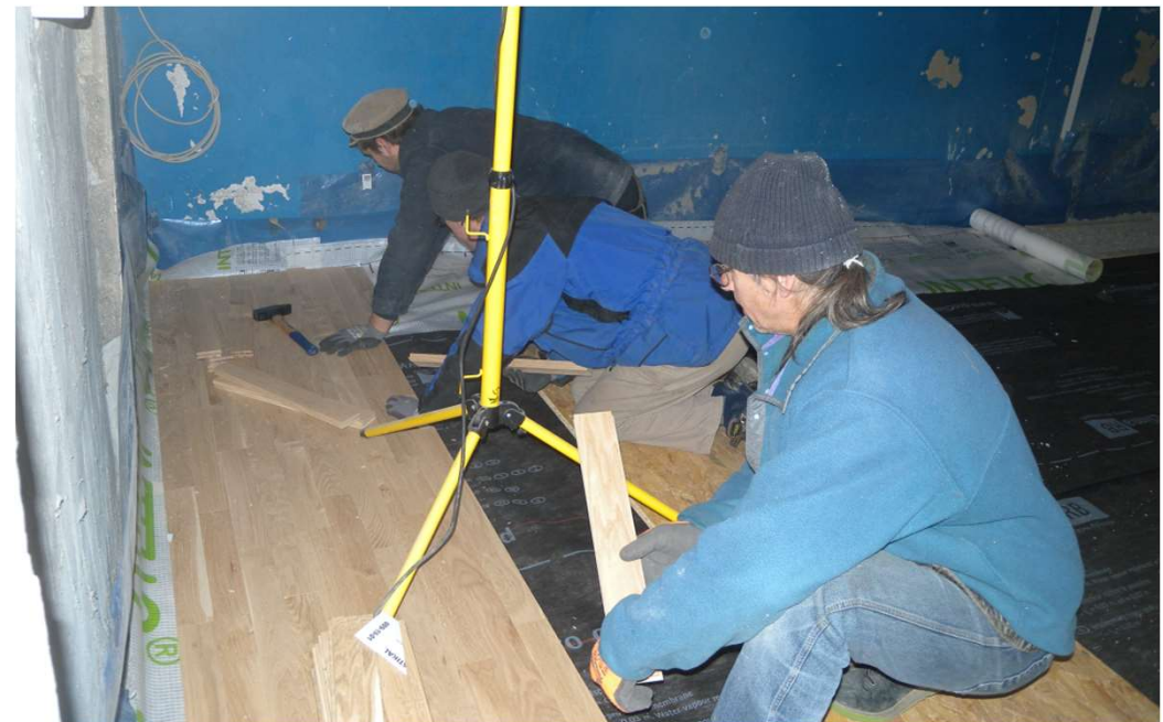
10 cm Dämmung im Boden – mehr ging nicht
